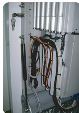
Integriertes Kabelmanagement für Strom, Netzwerk und KVM.
