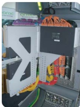
Vertiblade Halterungen ermöglichen vollen Zugriff auf jede einzelne Komponente.
